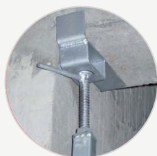
Blocage de la baie avec équerre à vis
